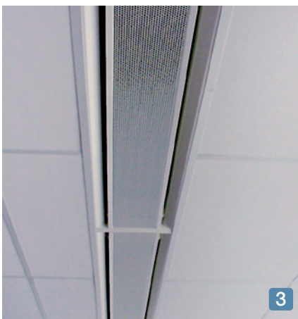
1+2 Aktiver Kühlbalken ABM 300 3 Einbaubeispiel Aktiver Kühlbalken ABM 300
